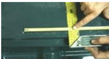
Uitmeten van de boorgaten
